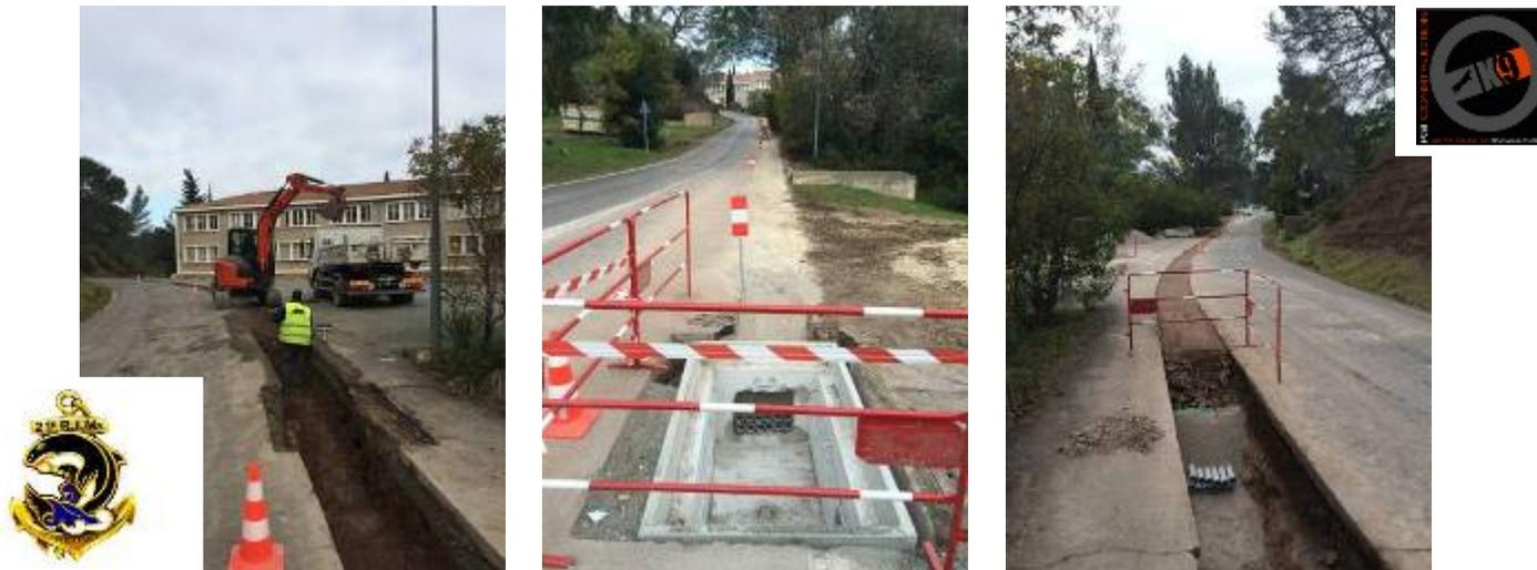
Fourniture et pose en tranchée de réseaux à Usage Fibre Optique sur 859.00ml composé 12 gaines LST Ø60 (soit L>10.000,00m)
